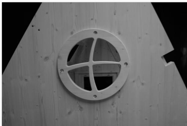
Danach bereiten Sie das Rundfenster für die Montage vor. Bohren Sie an den gewünschten Befestigungspunkten am Außenring Sacklöcher mit einem Forstnerbohrer mit  $\varnothing$  20 mm, ca. 8 mm tief vor (s. Bild links).
