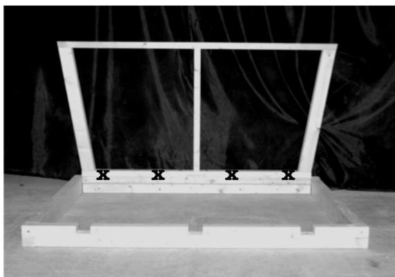
Wenn der Grundrahmen mit dem vorbereiteten Fundament verschraubt ist, können Sie mit der Aufstellung des Rückwandrahmens beginnen.
